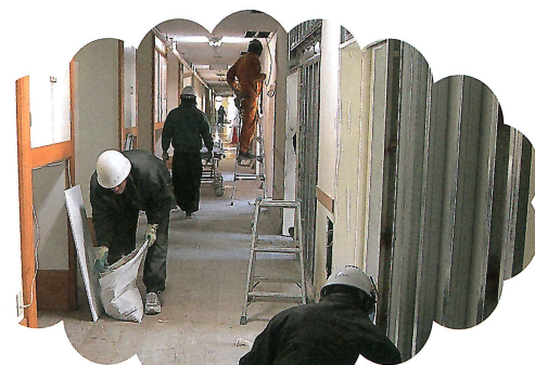
しずかの郷(勝山)も改修工事されました
